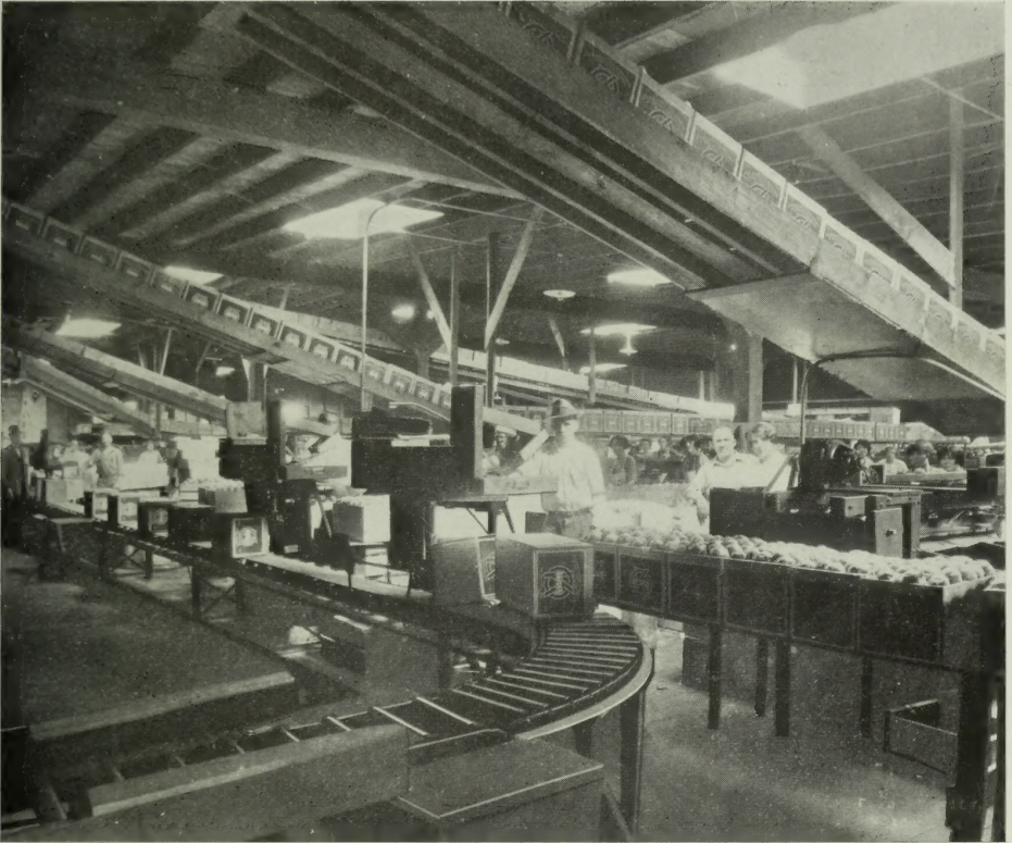
FIG. 26.— Une autre vue de l'intérieur d'un entrepôt d'emballage. A gauche, on voit le transporteur ou monte-charge à courroie en arrière des presses à caisses.
